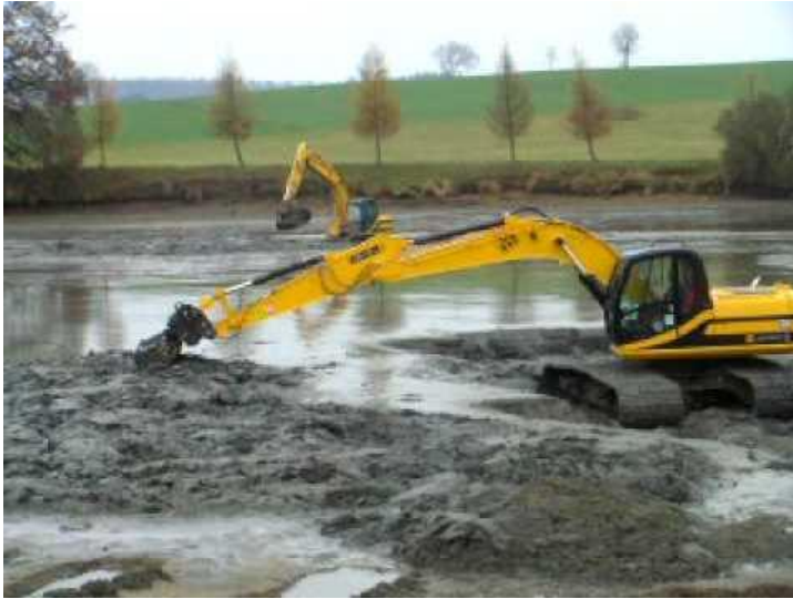
Kanalas kotrógép munka közben
